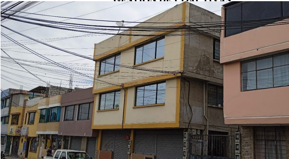
FACHADA FRONTAL DEL BIEN INMUEBLE
