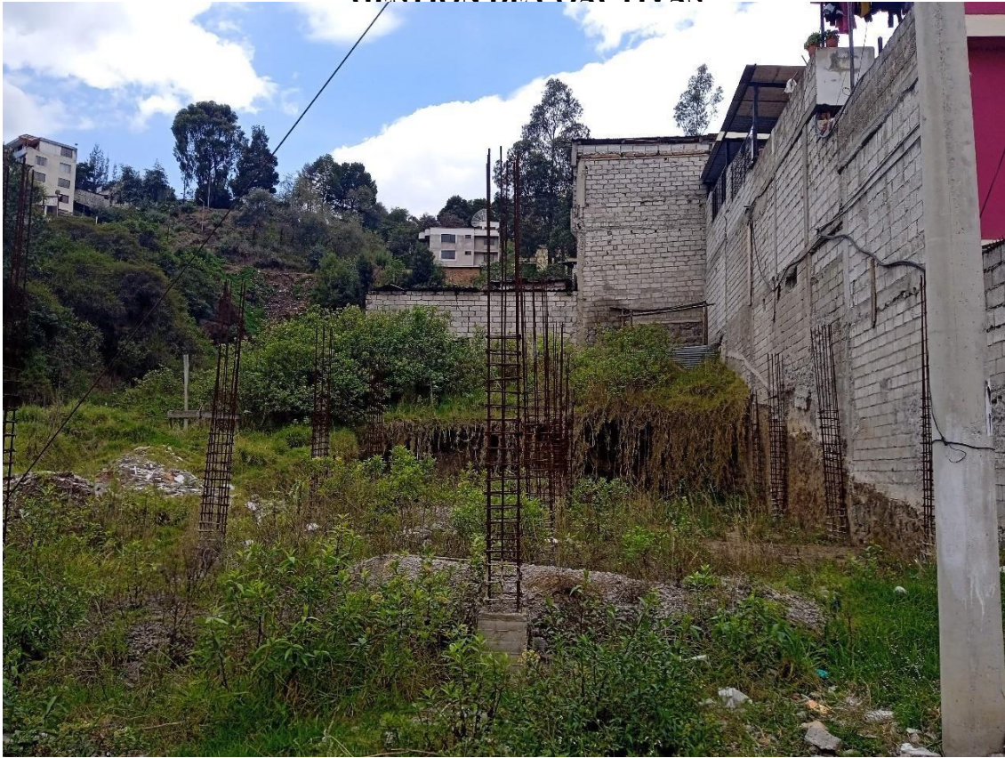
FACHADA FRONTAL DEL BIEN INMUEBLE
